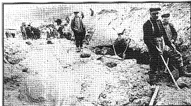
Préparation du terrain, au pic et à la pelle, pour l'installation des pipelines.
