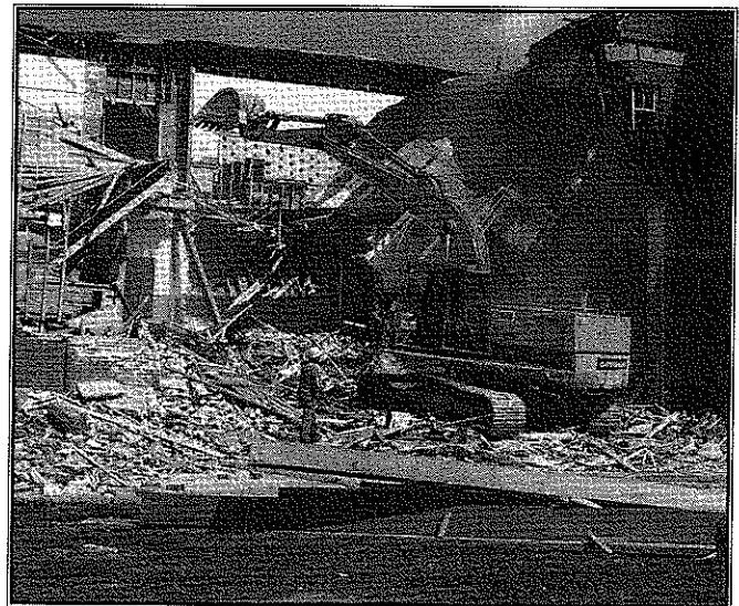
Démolition de l'école Ste-Thérèse.
