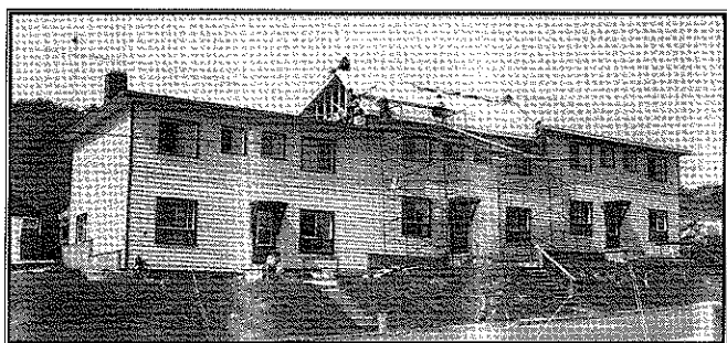
Le "Freight shed" de la 3e Avenue au moment des rénovations.
