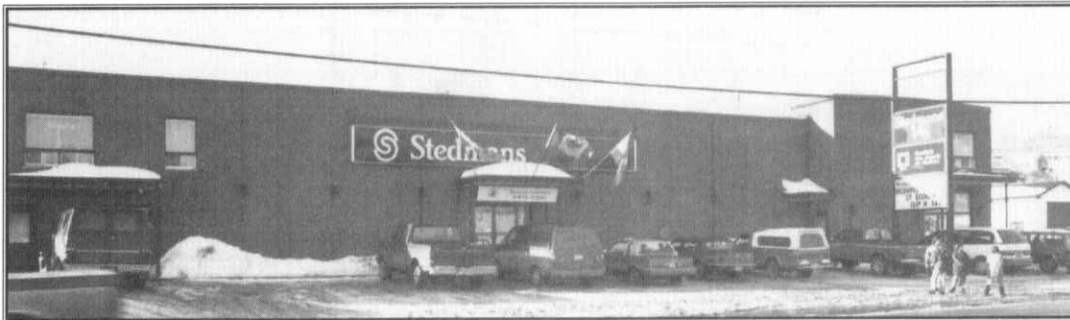
Le commerce Stedmans géré par les Marinier remplace, après agrandissement et rénovations, le "Théâtre Laurentien". La société des alcools du Québec a aussi un magasin dans cet édifice.
