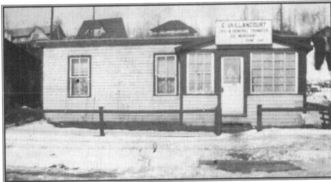
E. Vaillancourt. Taxi and General Transport, Ice Merchant, Phone: 143. Le bureau est situé à côté de la caserne des pompiers, sur la rue Kipawa.
